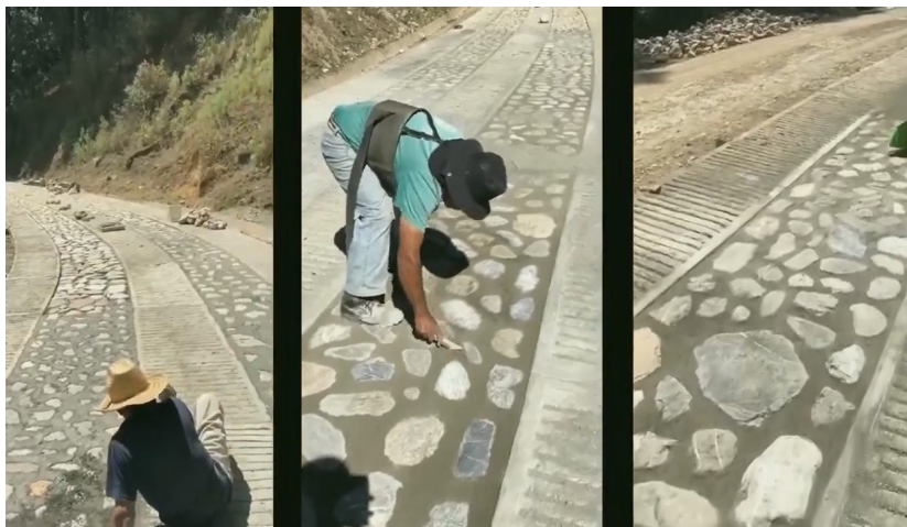
Diversos aspectos de la pavimentación del camino a la cabecera municipal de Atepec, Oaxaca https://www.youtube.com/watch?v=KDZge-AJVa8 .
